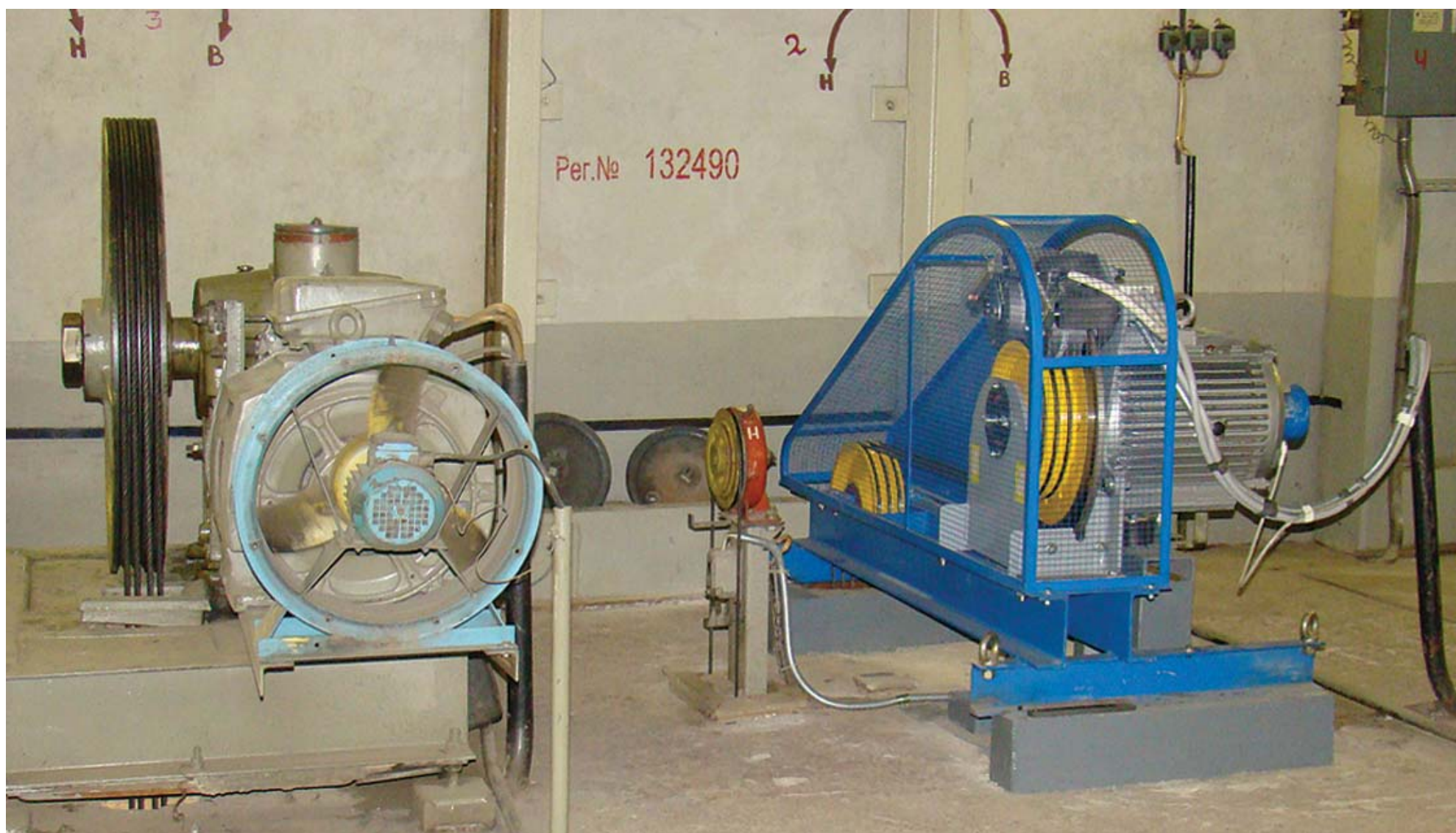
Редукторная лебёдка с двухскоростным двигателем и безредукторная лебёдка (после замены, в том же помещении)
